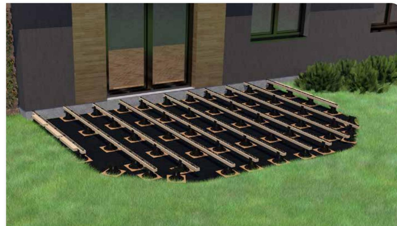
Construction de la base de l'ossature porteuse
