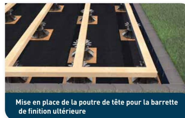
Mise en place de la poutre de tête pour la barrette de finition ultérieure
